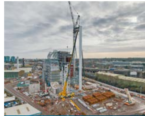
Q1 2024 Stack erection
